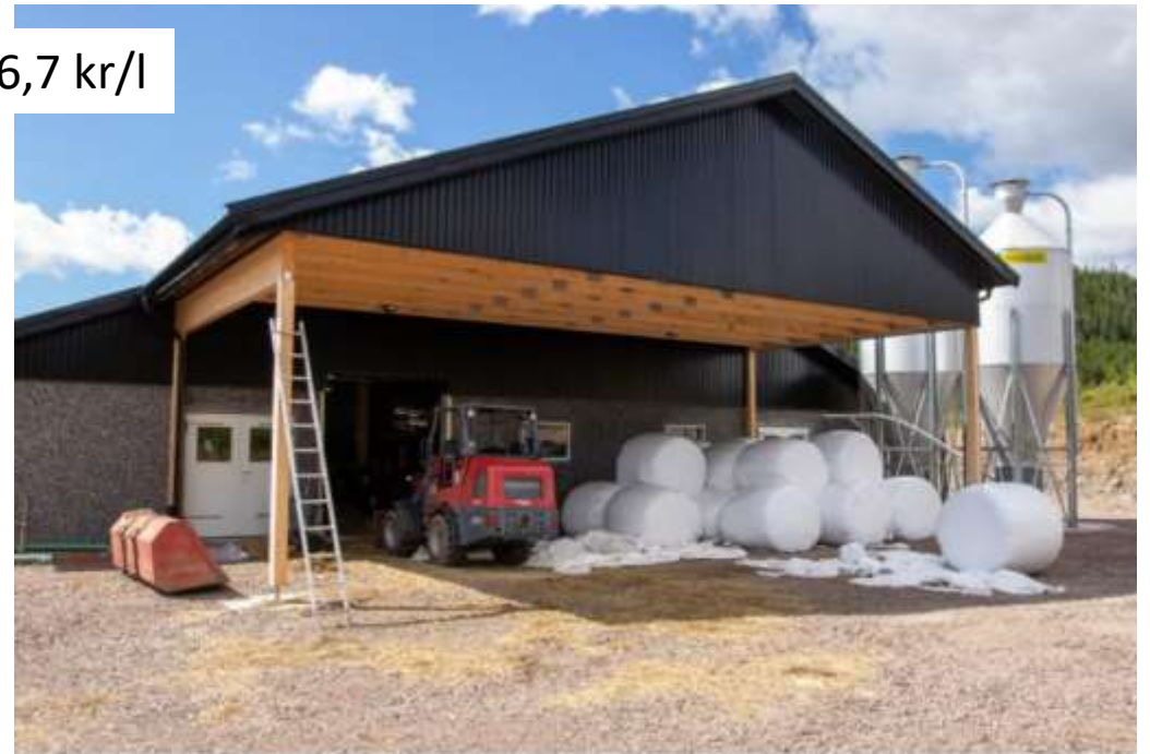
Førsentralen er bygd på utsida av fjøset ved at taket er strukket ut. Det foreligger planer om å kle veggene for å hindre at snøen føyer inn. Utfôringa skjer per nå med kompaktlaster. Foto: Morten Livenengen
